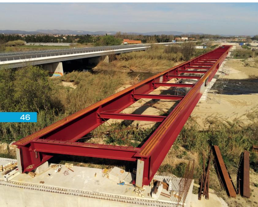
On notera sur le dessus des profilés les connecteurs (goujons soudés) qui lieront le tablier en béton avec la charpente lors du clavage final.
